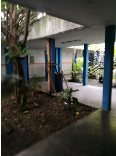
Pasillos de la supervisión en el CUM.
