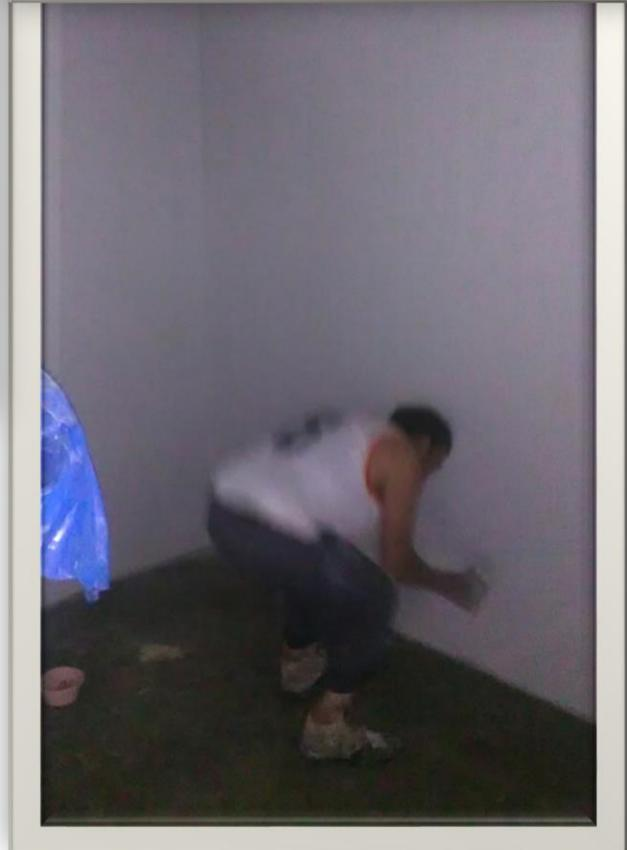
**Después:** finalización del repello, cernido vertical de las paredes de la auxiliatura.
