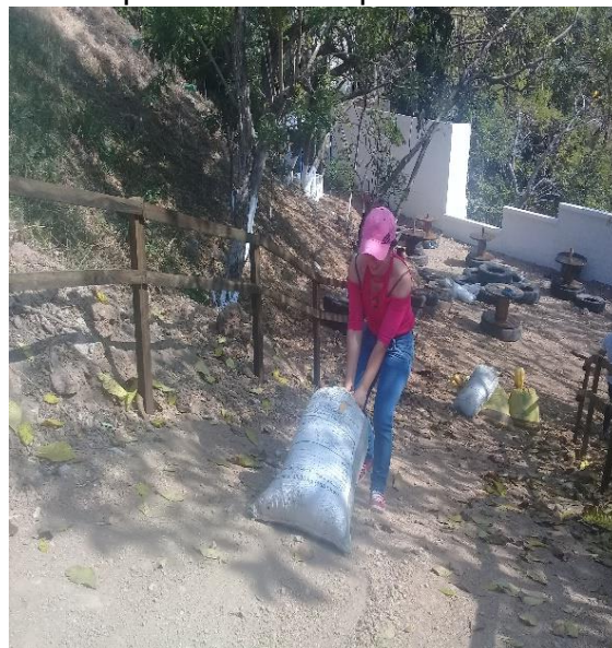
Foto No. 4 Transportando tierra para rellenar
