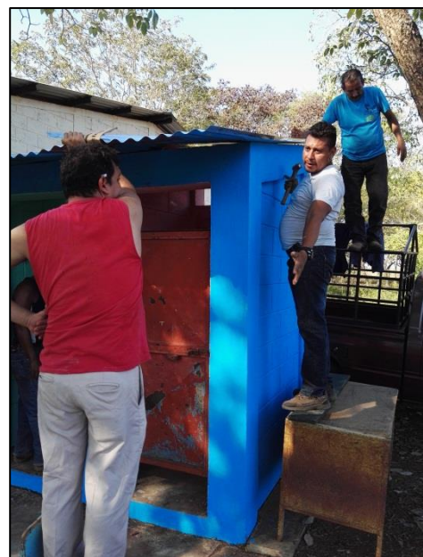
Epesista colocando techo nuevo de láminas a la infraestructura
