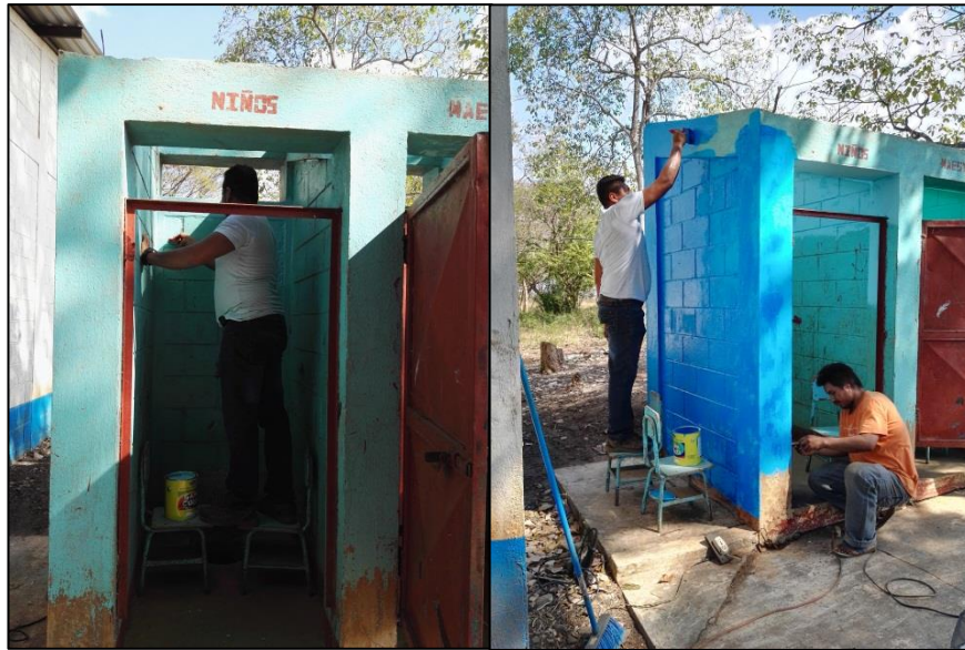
Epesista pintando la infraestructura para su remodelación
