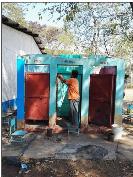
Epesista la colocación de puertas a la infraestructura para su remodelación
