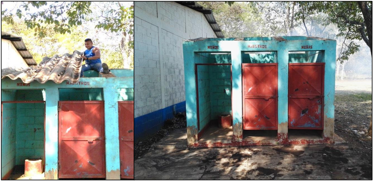
Epesista quitando las tejas de las letrinas para su remodelación
