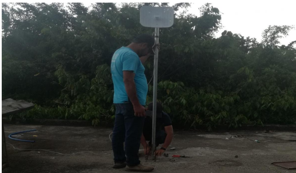
Fotografía 2. Los proveedores del servicio de internet están instalando el equipo necesario para el internet del establecimiento.
