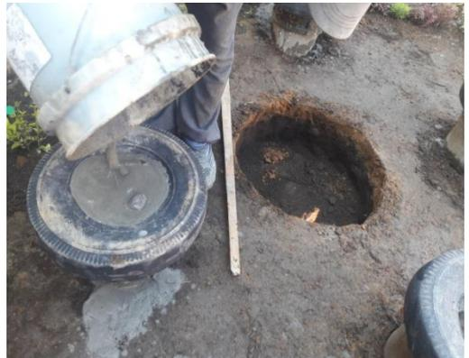
Foto8. Fundición con cemento y arena de bancos.
