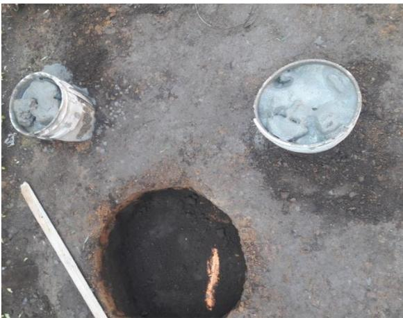
Foto 11. Fundición de las bases de los bancos utilizando como base cubetas de plástico.
