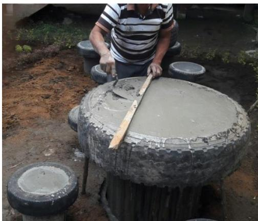
Foto10. Fundición con llantas de camión de rin 21.
