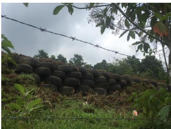
Foto: Reutilizando los neumaticos para construir muros.
