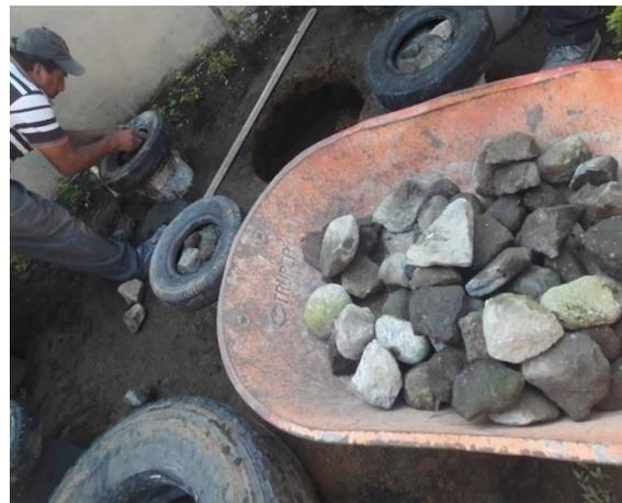
Foto 12. Fundición de bancos utilizando neumáticos rin 8.
