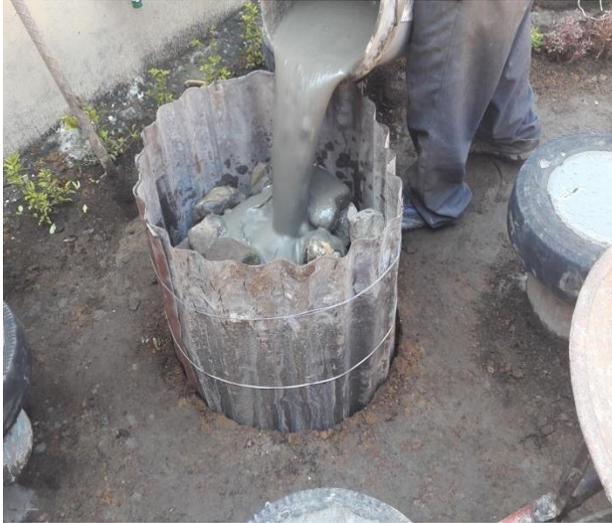
Foto 13. Fundición de las bases de las mesas utilizando como base laminas usadas.
