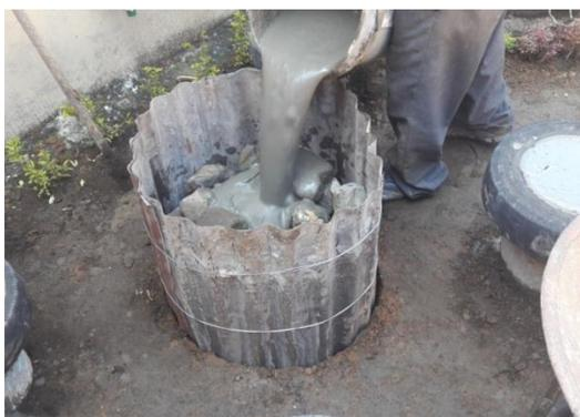
Foto9. Fundición utilizando láminas usadas.
