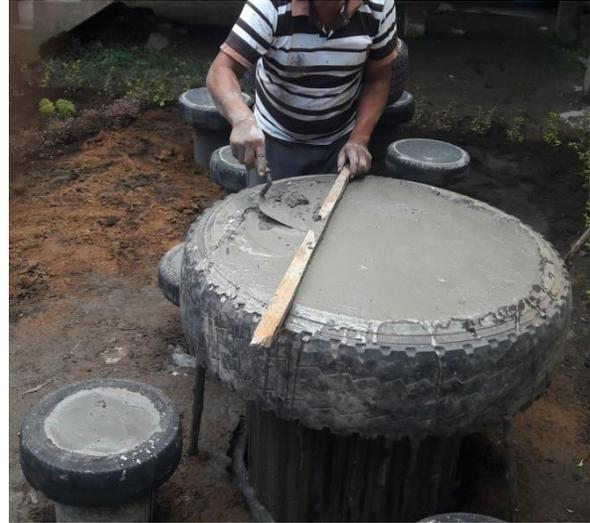
Foto 14. Fundición de las mesas utilizando como base neumático rin 25.
