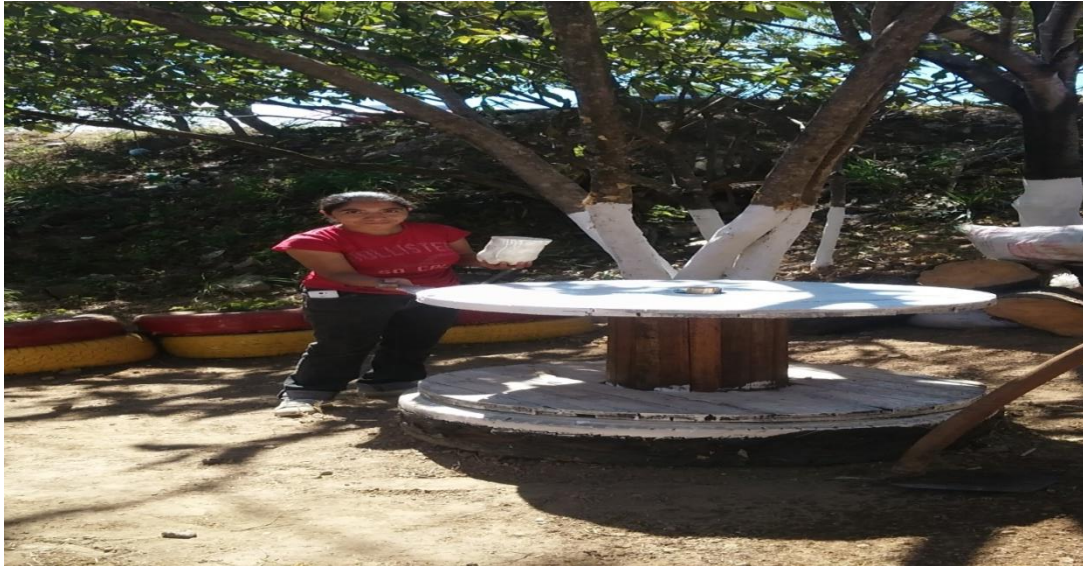
En la fotografía se ve que ya se le esta colocando la pintura a las mesas
