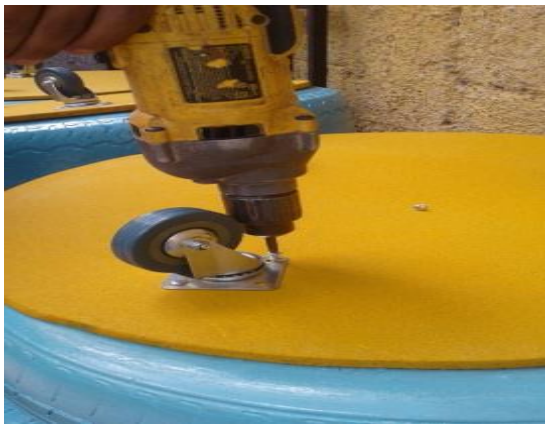
Figura No. 23: Atornillado de ruedas en la parte inferior de cada contenedor, haciendo uso de un barreno. Fuente: Epesista
