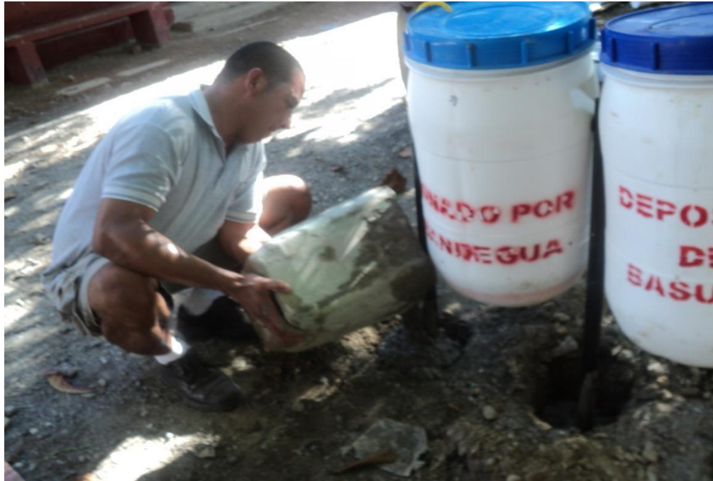
Vaciado de concreto en las bases de los captadores.
