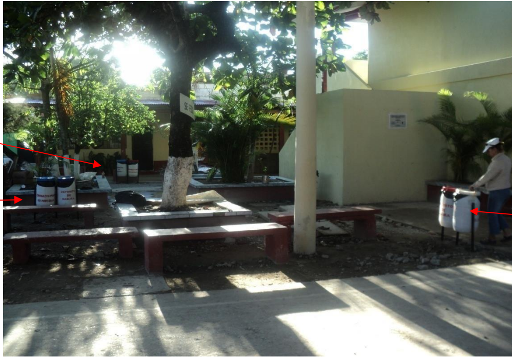
Finalización de instalación de los recolectores de desechos sólidos.
