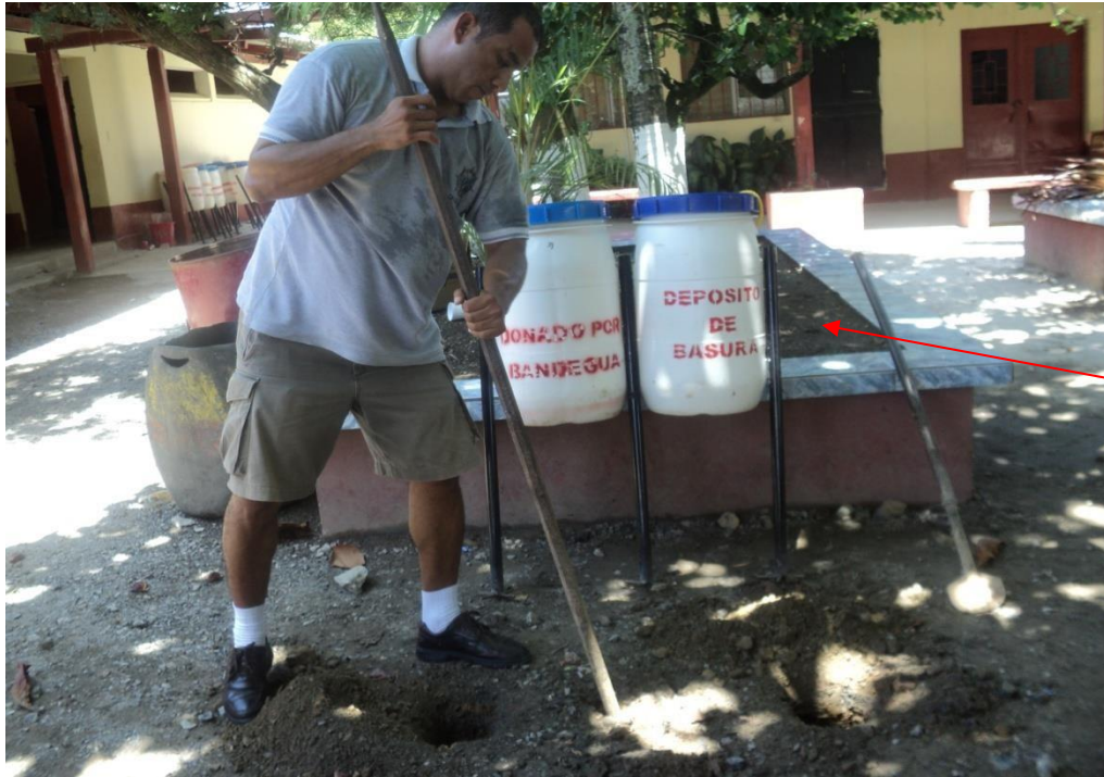
Perforación de hoyos.
