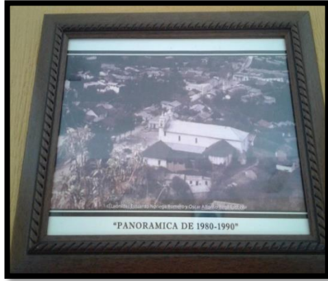
Fuente. Fotografía No. 5. Tomada por epesista. 29/08/2018
