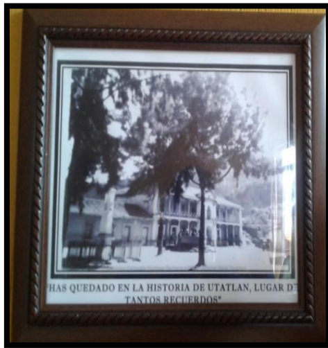
Fuente. Fotografía No. 7. Tomada por epesista. 29/08/2018
