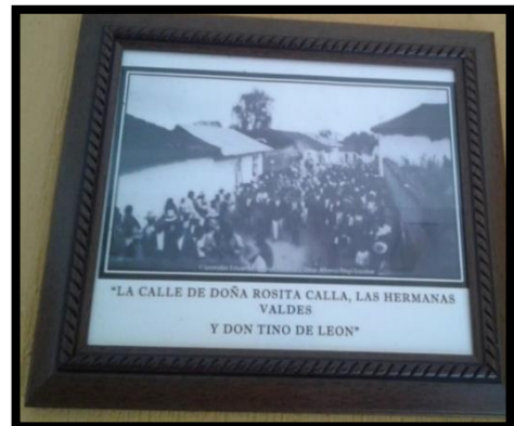
Fuente. Fotografía No. 4. Tomada por epesista. 29/08/2018
