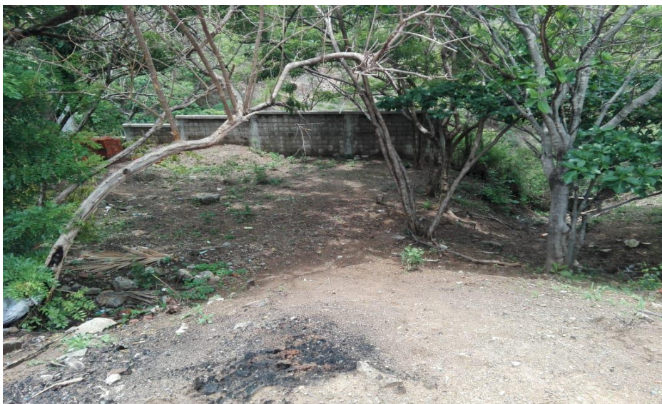
Fotografía No 4 limpieza de terreno
