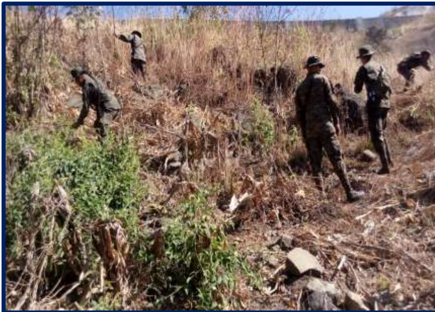
Ilustración 8. Limpieza del terreno. Se realizó la limpieza respectiva del terreno, en coordinación con los soldados del ejército. Fuente: Karen Castillo (2019)
