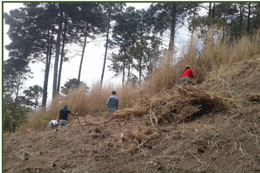
Ilustración 7. Limpieza del terreno.
