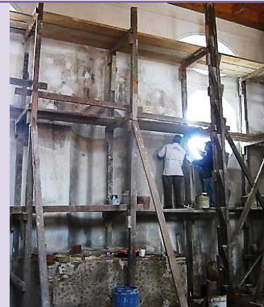
Foto # 58 Remozamiento de muros en la nave central, consiste en la aplicación de capas alisadas de cal y arena (Repello). (Chalí, 2018)
