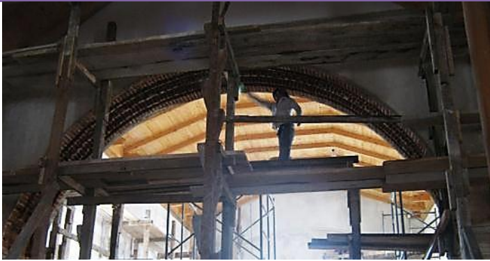
Foto # 57: Trabajos con propósitos de afirmación de arco de medio punto, instalando ladrillos de barro. Se observa el alfarje del área del presbiterio.
