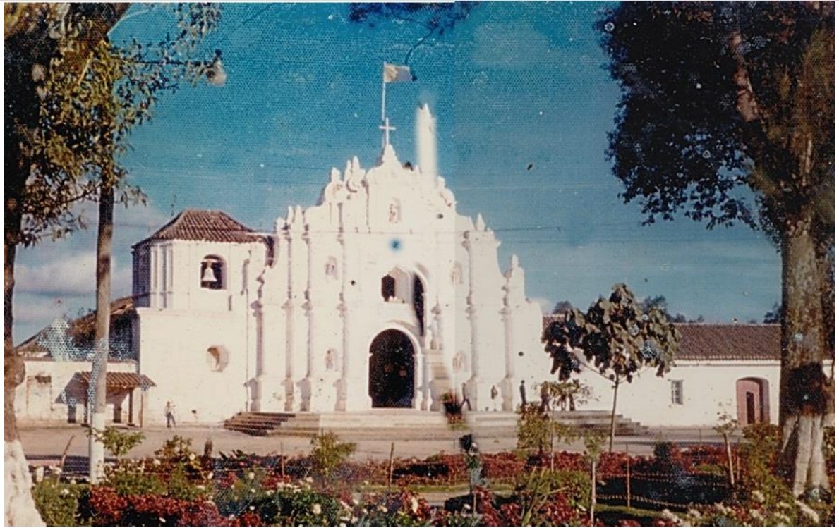
Imagen # 4: Fachada de la iglesia, posiblemente en los inicios de 1980. La apariencia de las áreas aisladas, especialmente los muros, han tenido cambios para acomodarse a necesidades que surgen en la actualidad
