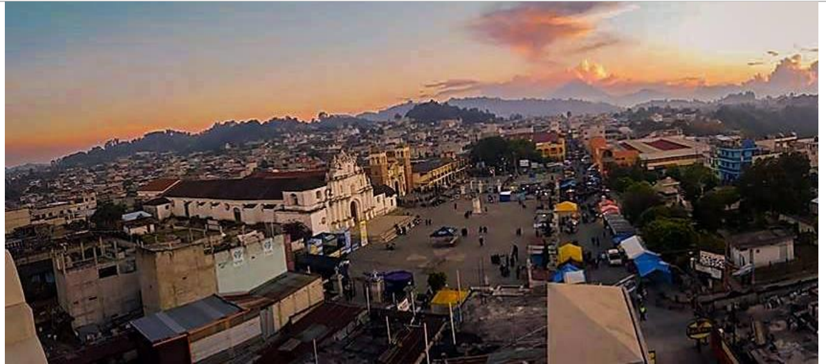
Foto # 51: Panorámica del municipio de Comalapa, resalta en el área central, la plaza y la iglesia San Juan Bautista.
