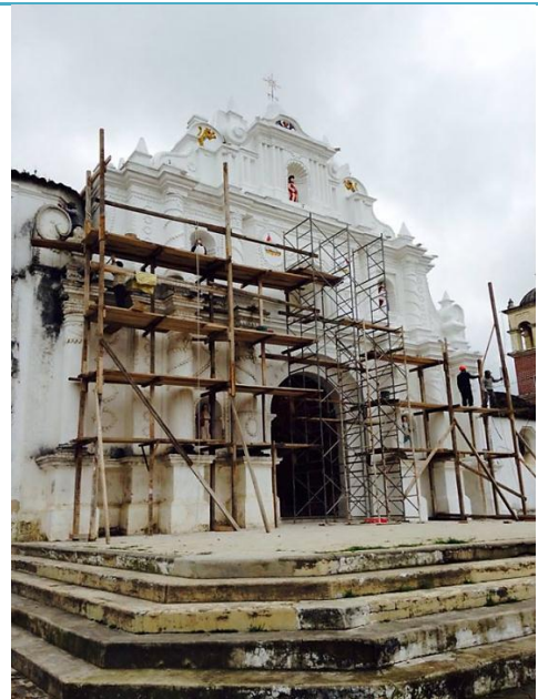
Foto # 65: andamio utilizado para coloración de la fachada. (Chalí, 2018)
