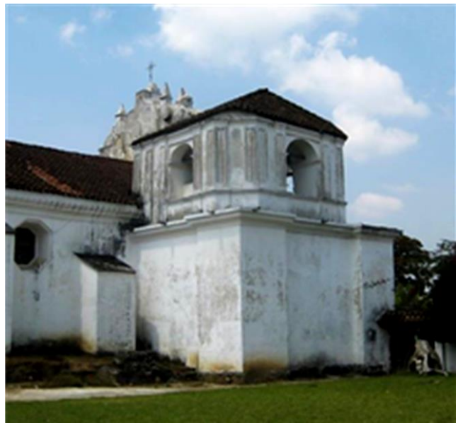
Foto # 23: Vista posterior del campanario, resalta en segundo cuerpo: vanos con arco de medio punto y pilastras estriadas. El primer cuerpo constituye la capilla interna.
