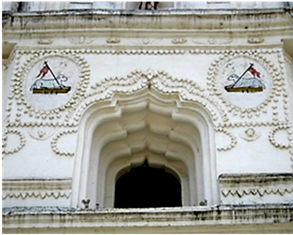
Foto # 33: Corderos en la fachada, resalta ventana de arco conopial abocinada. (Chalí, 2018.)
