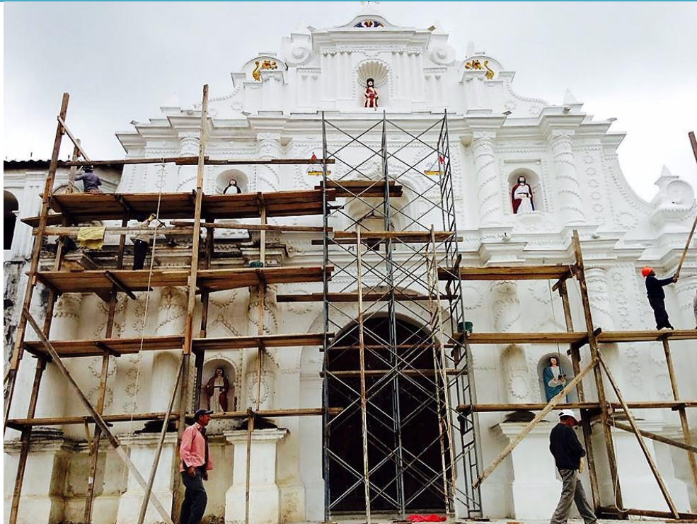
Foto # 64: limpieza y aplicación de pintura en fachada. (Chalí, 2018)
