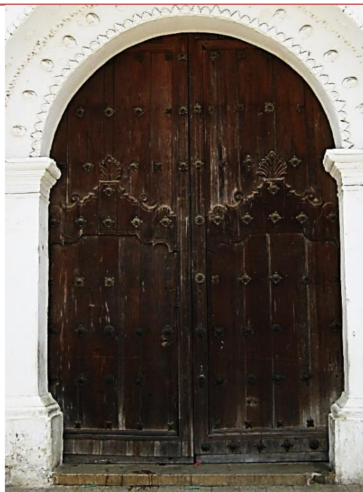
Foto # 13: Detalle de portón principal. (Chalí, 2018)
