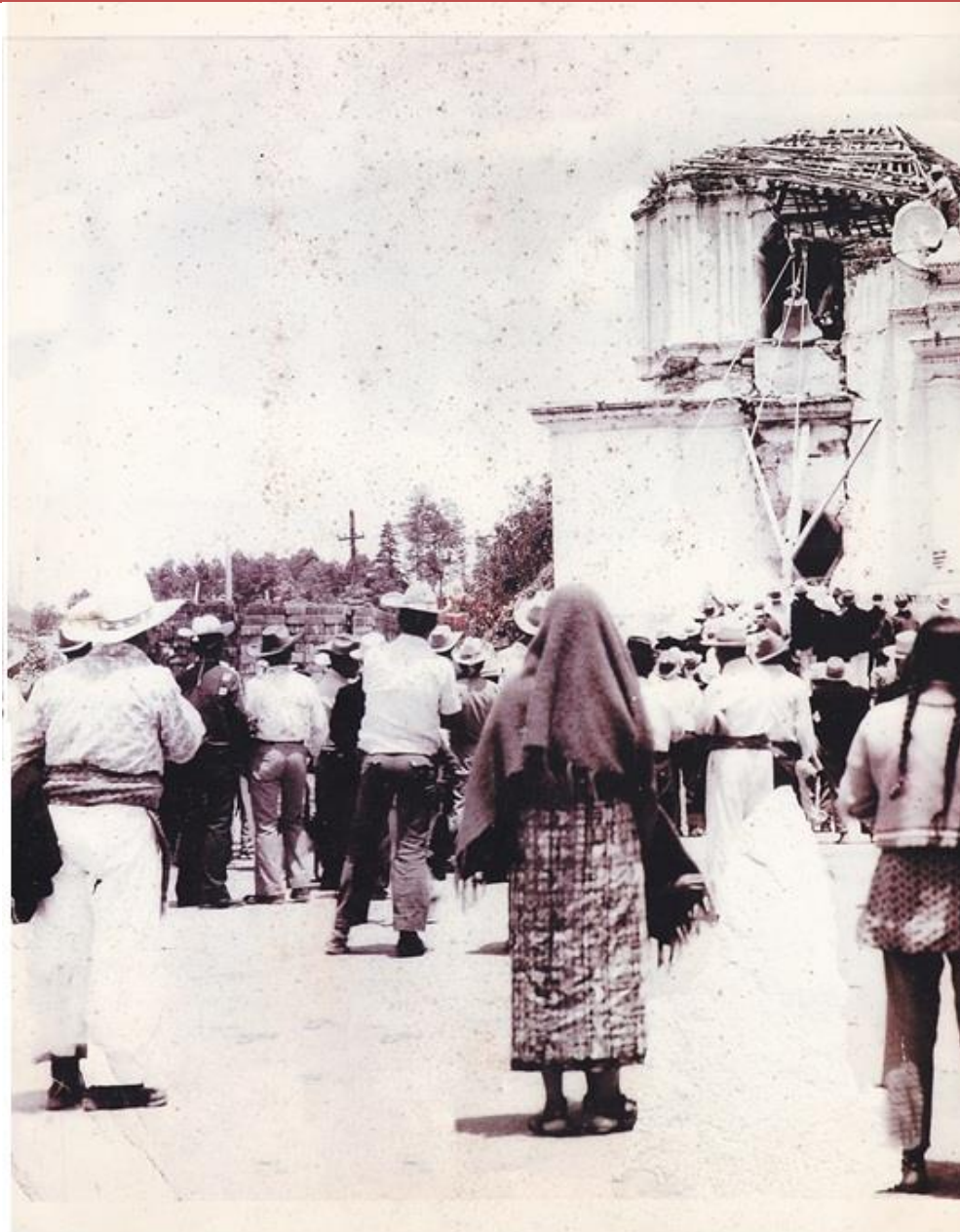
Imagen # 10: Bajando la campana. La feligresía ha sido el principal motor, para que el estado de la iglesia siga manteniéndose levantada. Arduo trabajo conlleva su preservación, compromiso voluntario que la población realiza con mucha dedicación.
