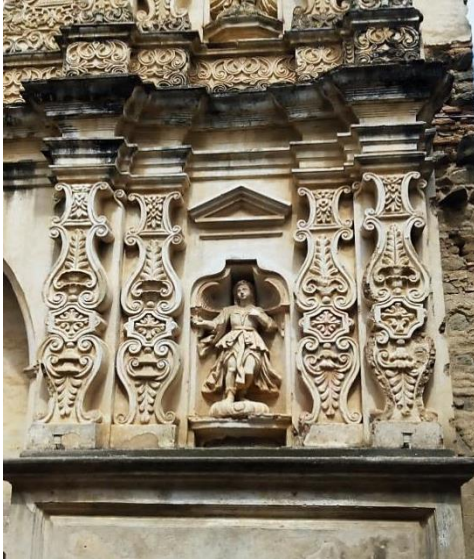
Foto # 2: Detalle de pilastras serlianas en el exconvento de Santa Clara, Antigua Guatemala. (Chalí, 2018)
