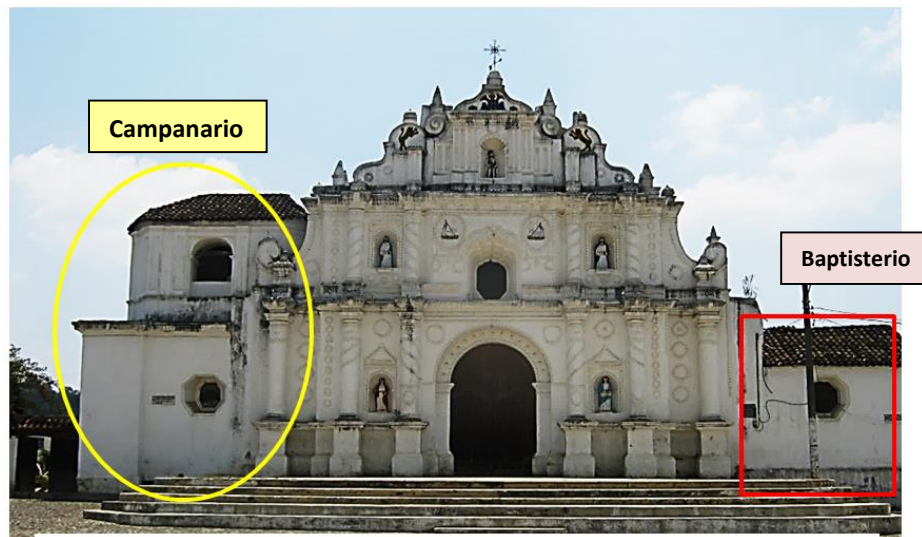
Foto # 24: Ubicación de campanario y baptisterio en la fachada. (Chalí, 2018)
