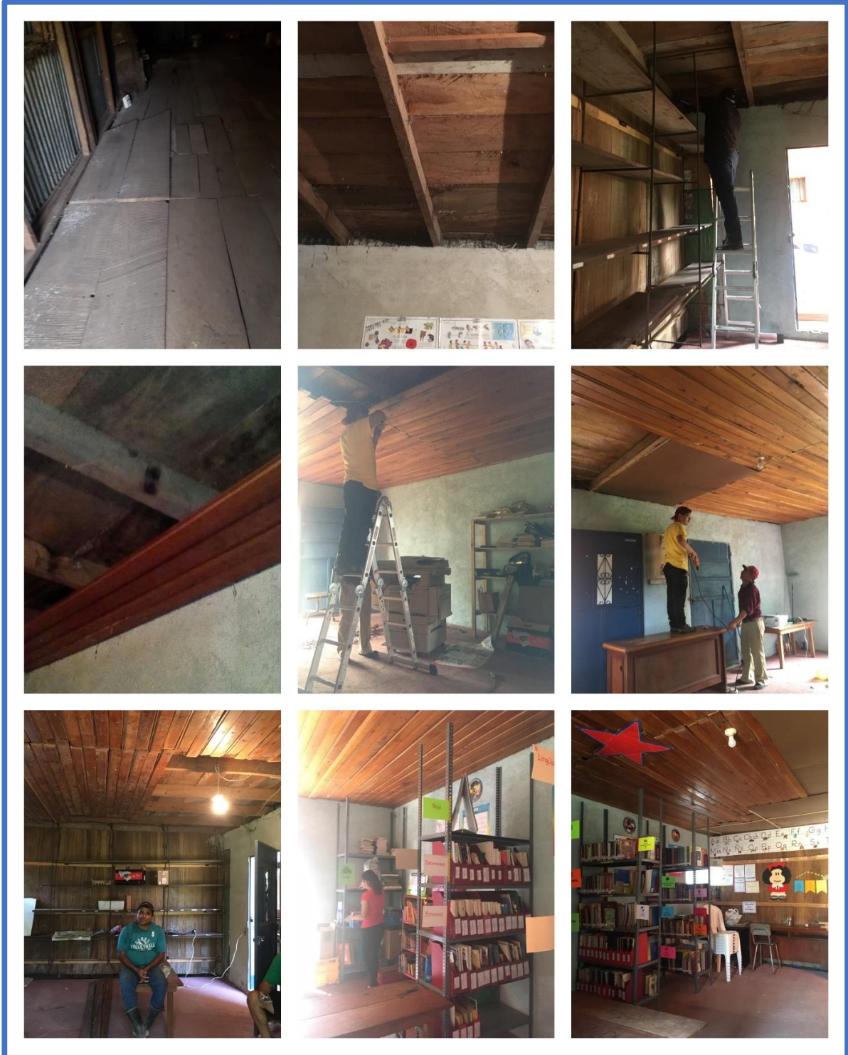
Galería No.1. Evidencia de los trabajos realizados antes, durante y después en el techo de la biblioteca comunitaria.
