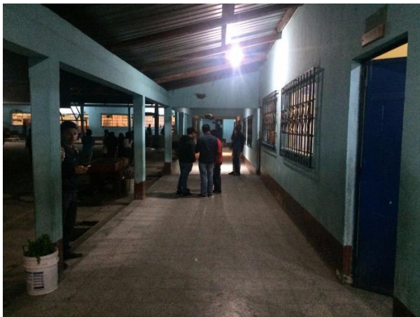
Figura 12. Corredor del establecimiento.
