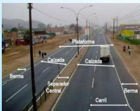
Figura 5. Partes de una de las vías públicas (carretera) Fuente: Minedu. MTC
