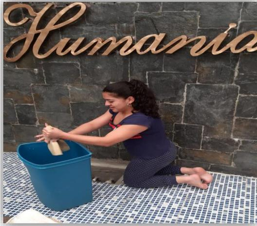
Descripción: Se procedió a limpiar la baldosa para la aplicación de Sika 101 para impermeabilizar a base de cemento y sikalatex en líquido para sellar cualquier filtración de agua en la fuente.
