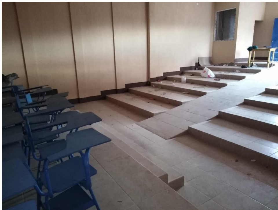
Figura 80. Franco S. (2019). Nuevo Auditorio Instituto Nacional de Educación Básica Santa Isabel II Villa Nueva [Fotografía]. (Salón designado para la realización del proyecto)
