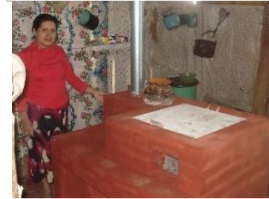
Estufa con planchas de metal hecha de arena y barro
