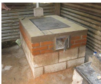
Estufa con hornillas hechas de block y ladrillos
