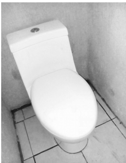
Imagen 6. Área de baños terminada de pintar con sanitarios y pisos nuevos, en la EOUM, Los Almendros.
