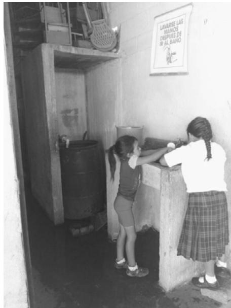
Imagen 2. Área de sanitarios de la EOUM Los Almendros. Previo a la realización del proyecto.
