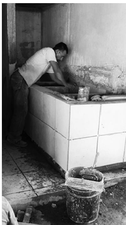
Imagen 5. Construcción de pileta en el área de sanitarios, EOUM, Los Almendros.
