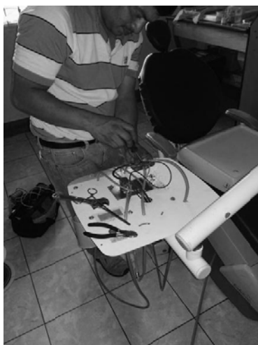
Imagen 7. Colocación de mangueras nuevas para la unidad dental.
