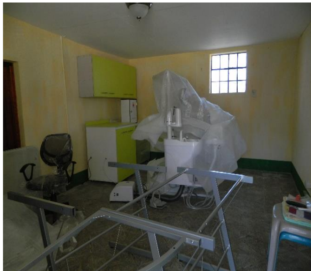
Fotografía 7: estado inicial de la clínica
