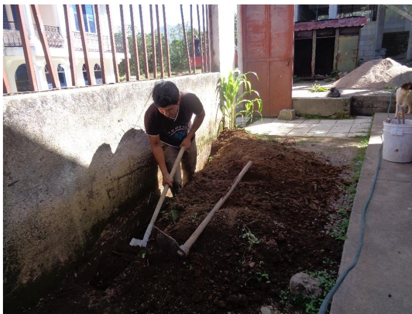
Fotografía 1: Primer día de la construcción de la pila.
