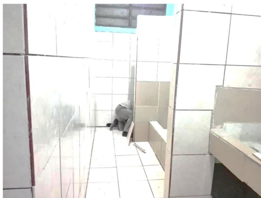
Figura No. 10. Sanitarios de hombres después de la remodelación
