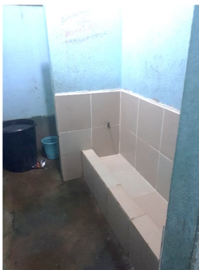
Figura No. 6. Mingitorio previo a la remodelación
