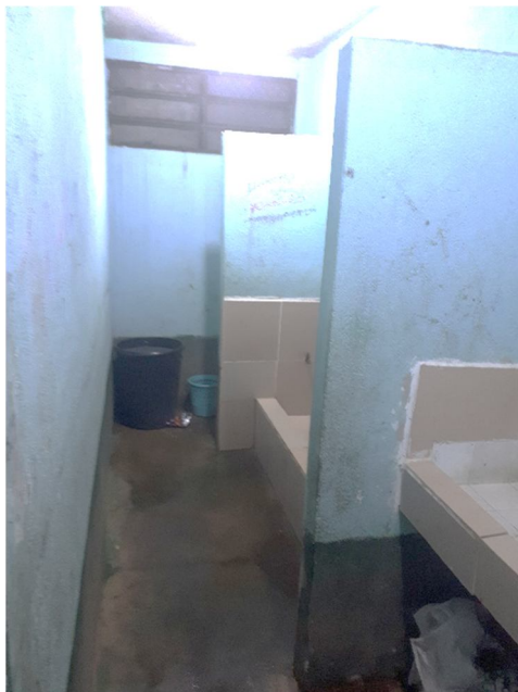
Figura No. 3. Sanitarios de hombres previo a la remodelación
