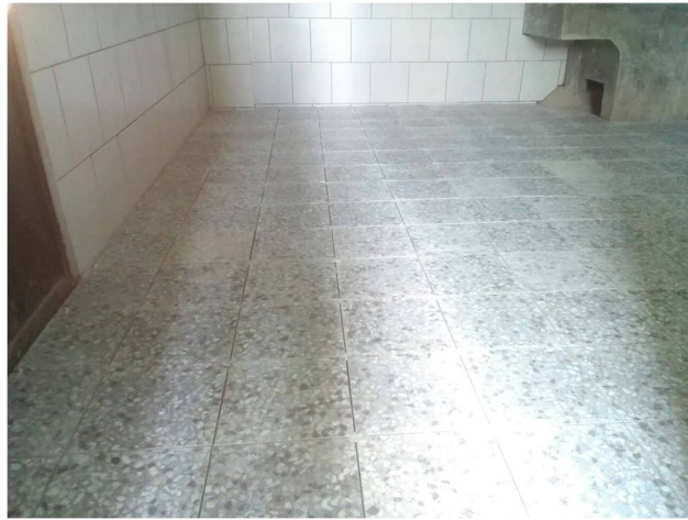
Figura No. 7. Área de la cocina remodelada
