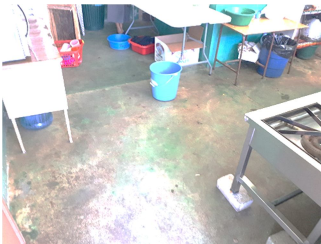
Figura No. 1. Área de la cocina previo a la remodelación
