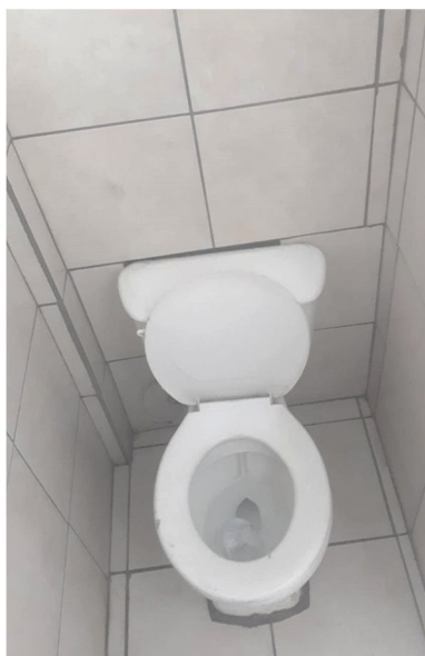
Figura No. 11. Sanitarios de hombres remodelados
