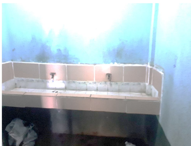
Figura No. 2. Lavamanos de los sanitarios previo a la remodelación
