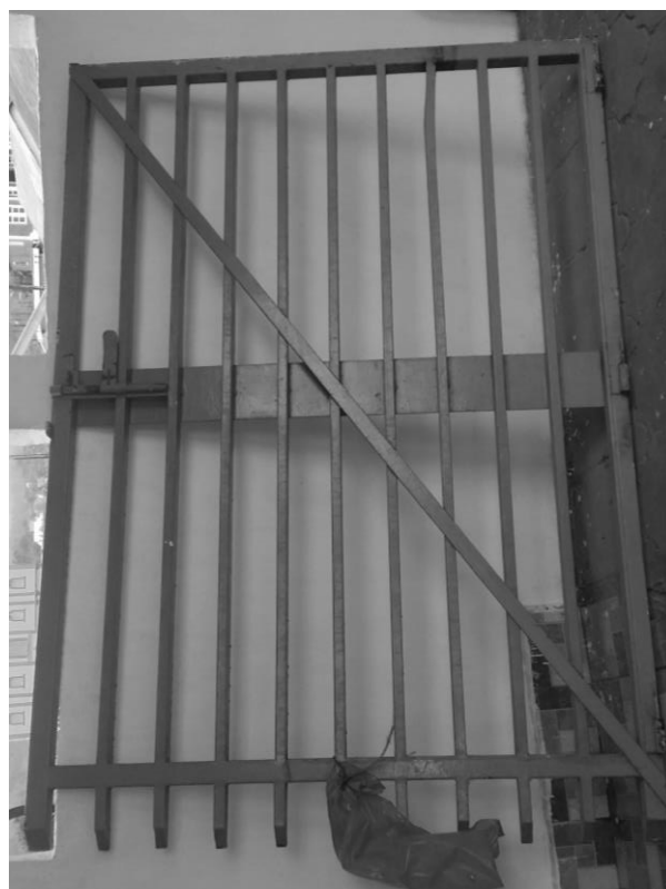
Figura 8. Portón Metálico que se dejó para su posterior instalación, para resguardar la entrada de la clínica parroquial. Fuente: EPS 2017 – 2018, Aldea El Aguacate, Nentón, Huehuetenango.
