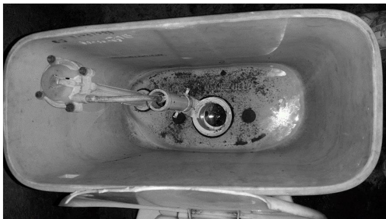
Figura 4. Tonel donde los niños recolectaban el agua para el sanitario, ya que este no contaba con el sistema de árbol de flote y sapo. Fuente: EPS 2017 – 2018, Aldea El Aguacate, Nentón, Huehuetenango.
