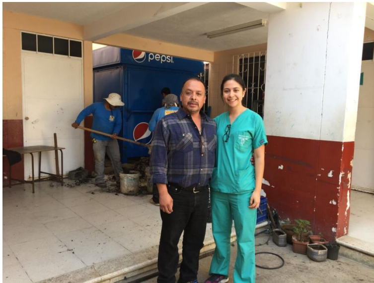
Imagen 7 Director y Odontóloga Practicante durante la instalación de la caseta en la Escuela Oficial Rural Mixta No. 822
