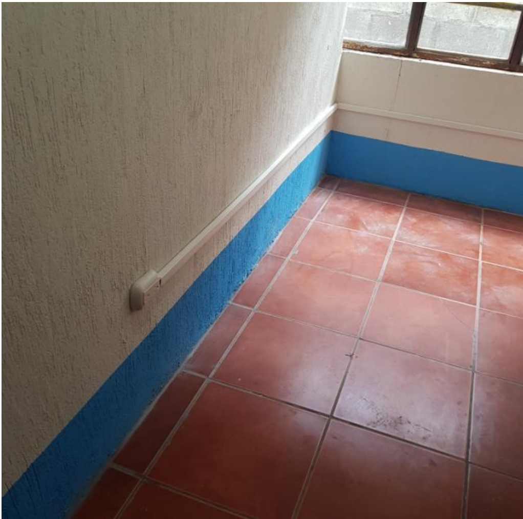
Imagen 6. Instalación de tomacorrientes en el cuarto auditivo donde eran necesarios para conectar aparatos eléctricos y no se contaba con ninguno
