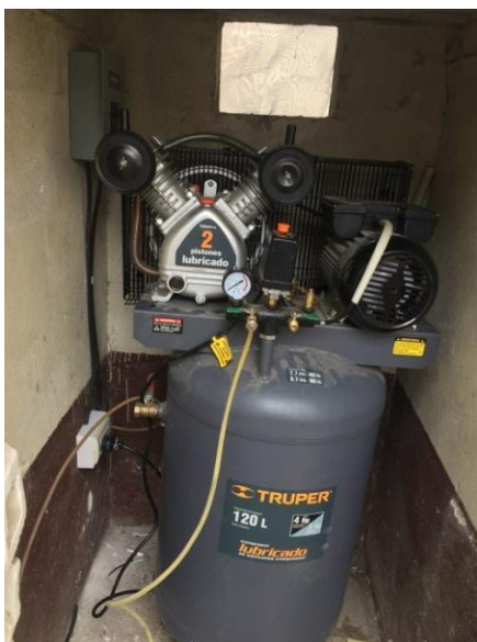
Figura No. 4. Instalación de caja de flipones y tomacorrientes por parte del Ministerio de Salud Pública y Asistencia Social
