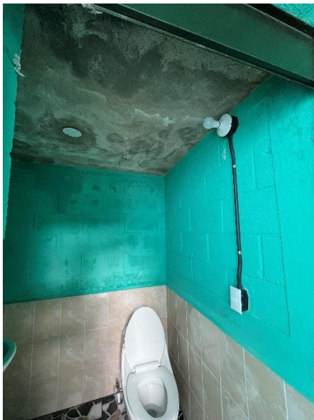
Imagen 11. Reinstalación de bombilla en pared lateral, evadiendo filtración de agua.
