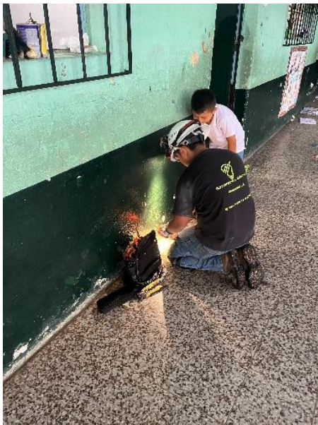
Imagen 9. Proceso de reparación de tomacorrientes en pasillo de la escuela.
