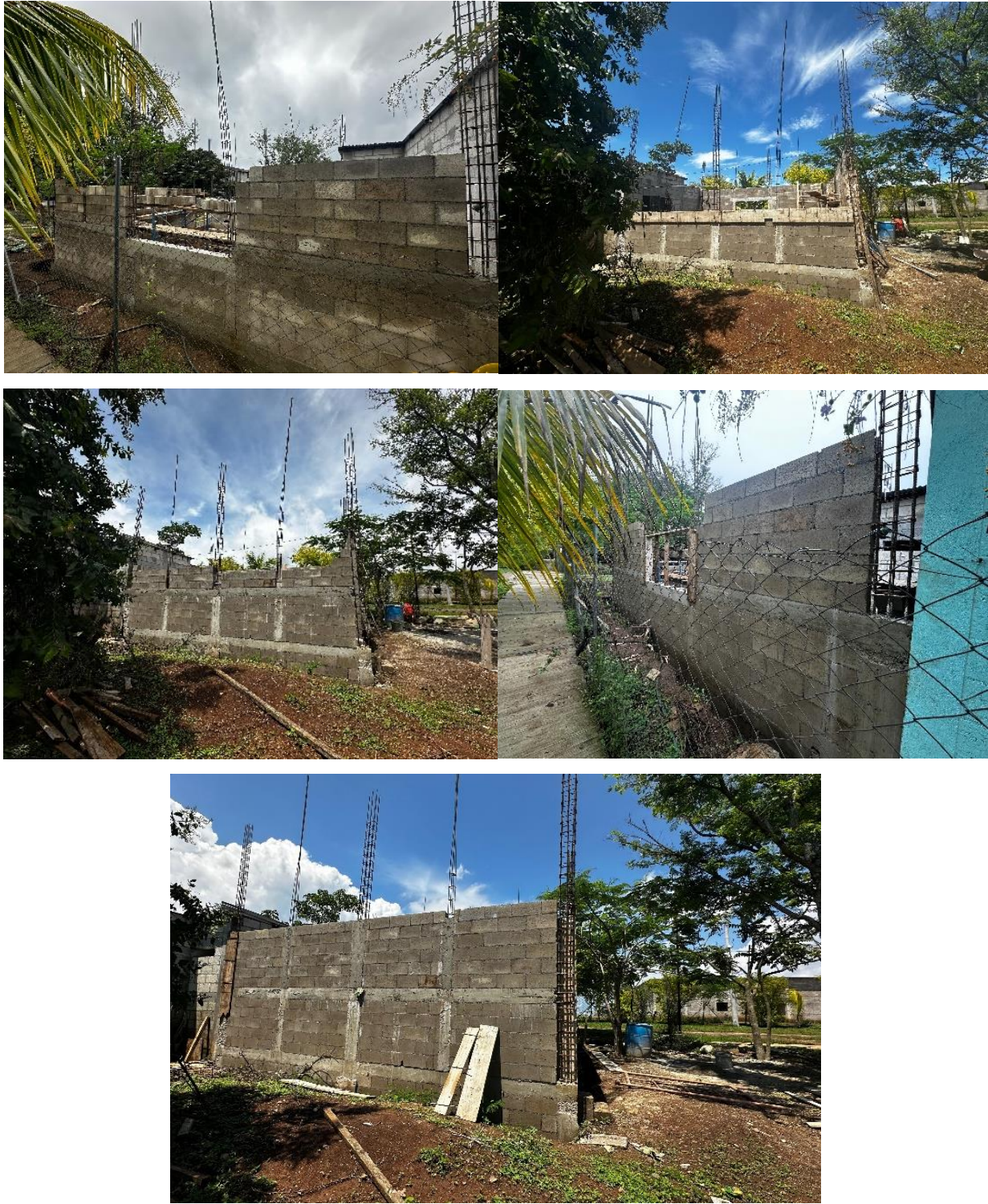
Imagen 10. Delimitación de ventanas y puerta de entrada.
