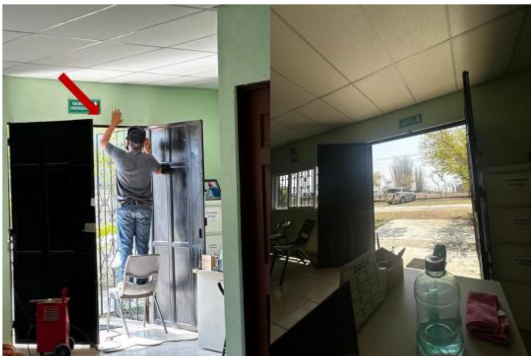
Imagen 14. Reparación de puerta de entrada a la clínica.
