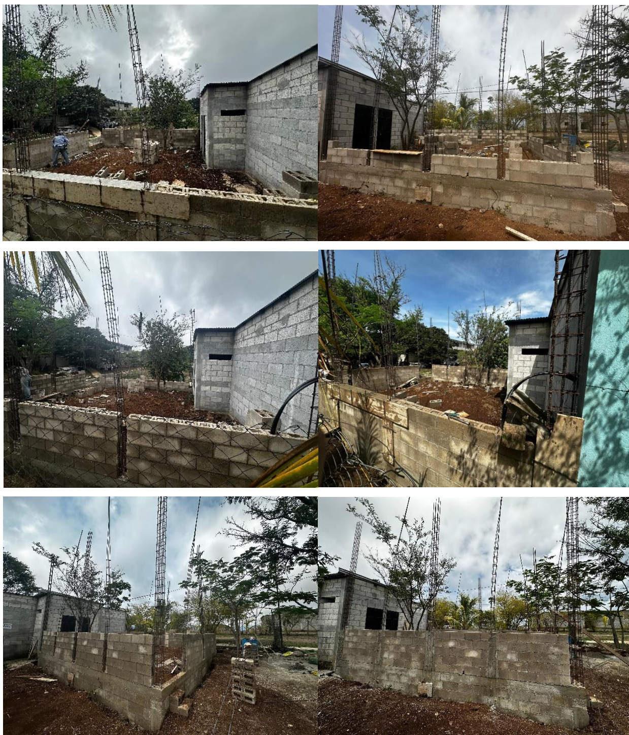
Imagen 9. Levantamiento de paredes con block.
