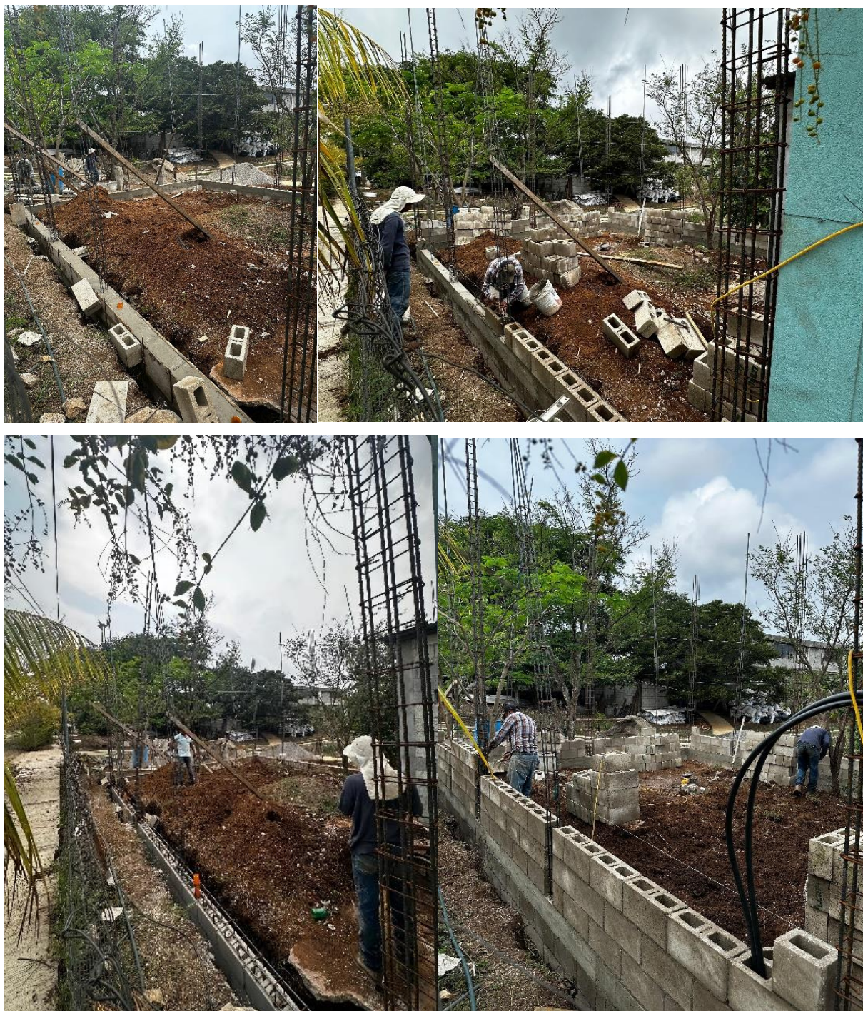
Imagen 8. Fundición de columnas para iniciar a levantar paredes.
