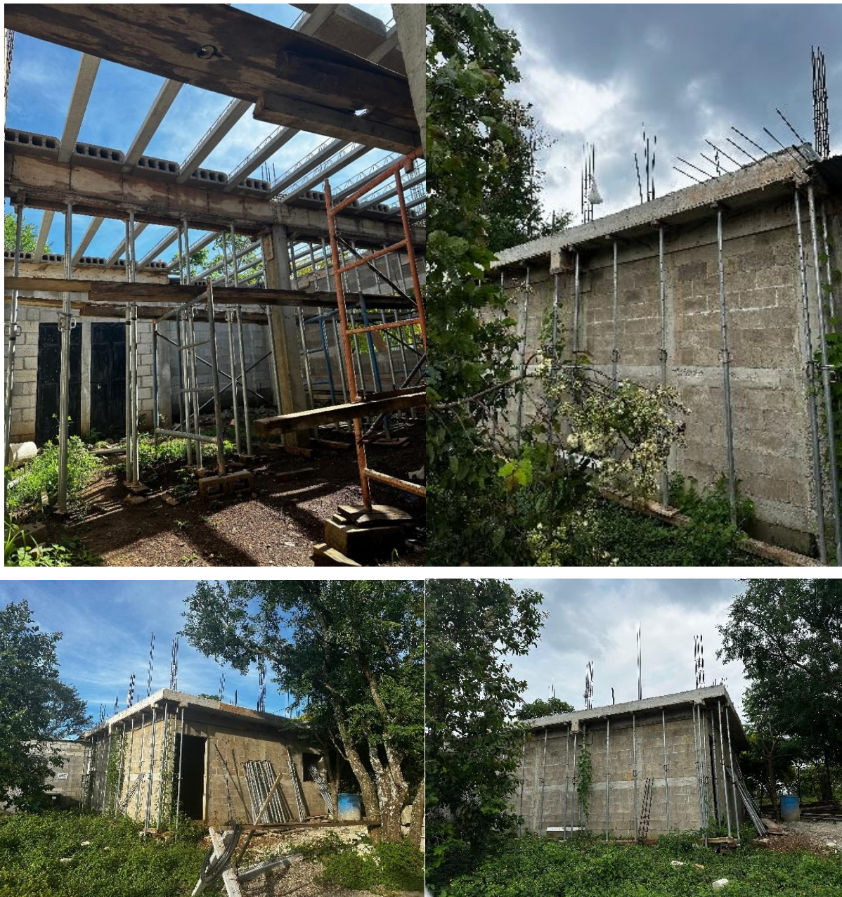
Imagen 12. Fundición de terraza para planificación de segundo nivel. Concluyó obra gris.
