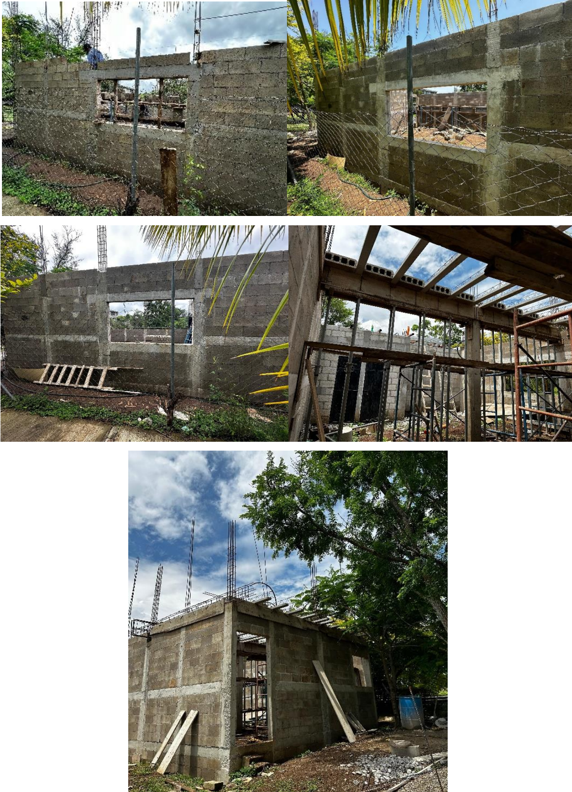
Imagen 11. Concluyó el levantamiento de paredes y se inició con la elaboración del andamio para fundición de terraza.
