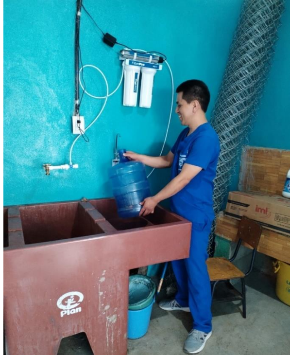
Fotografía de la prueba de funcionamiento del filtro de agua.
