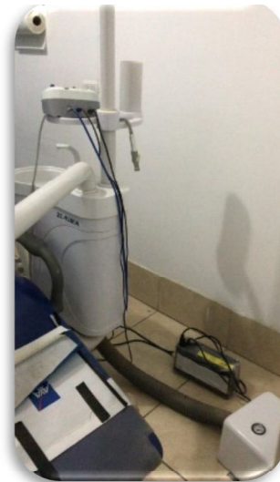
Imagen 8. Regulador de voltaje, uno para cada unidad dental (UPS)
