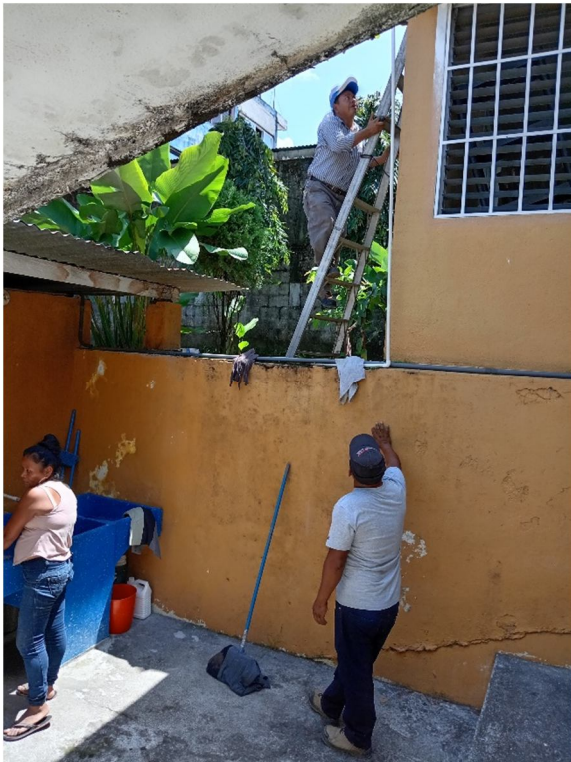
Figura 89. Cableado nuevo de la caja central al compresor.
