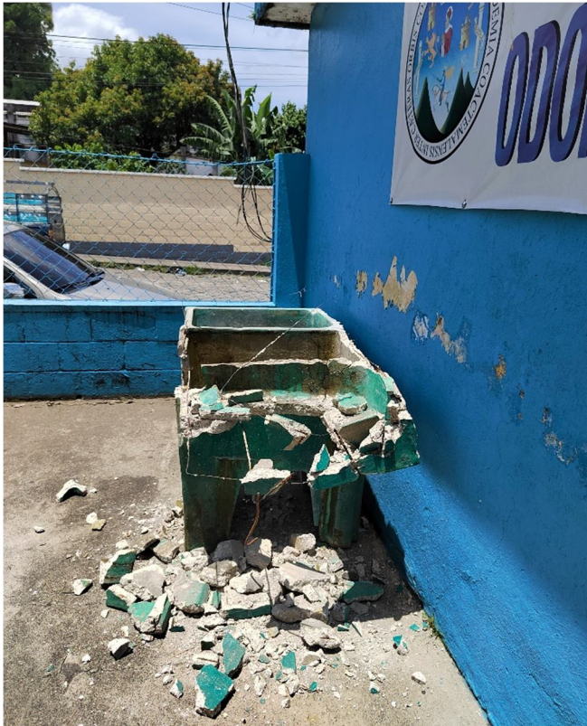
Figura 85. Remoción de la Pila abandonada en la entrada del módulo.
