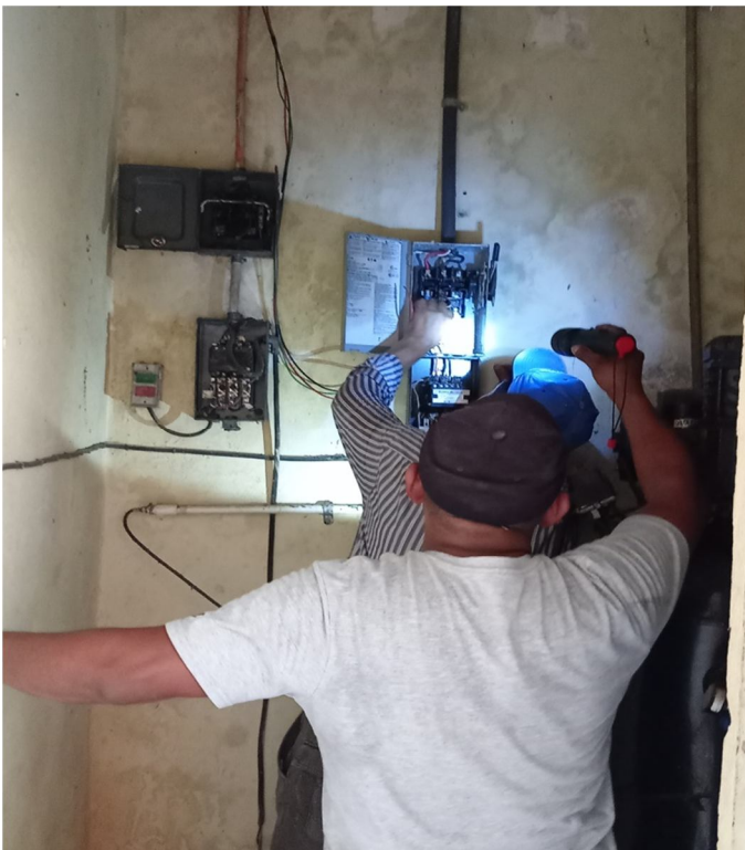
Figura 86. Reparaciones eléctricas de la caja del compresor.
