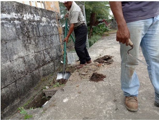
Figura 90 y 91. Cambio de llave de paso central.
