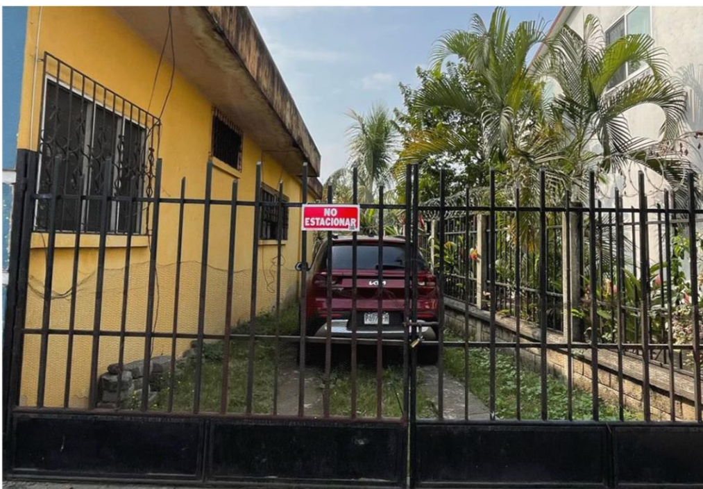
Imagen 13 y 14. Antes y después de la colocación de rótulo de identificación de “NO ESTACIONAR” en el ingreso vehicular del Módulo Odontológico de San Martín Zapotitlán, Retalhuleu, Guatemala.
