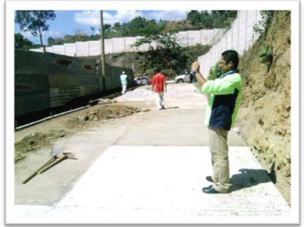
Toma de fotografías a proyectos de infraestructura en la zona 21
