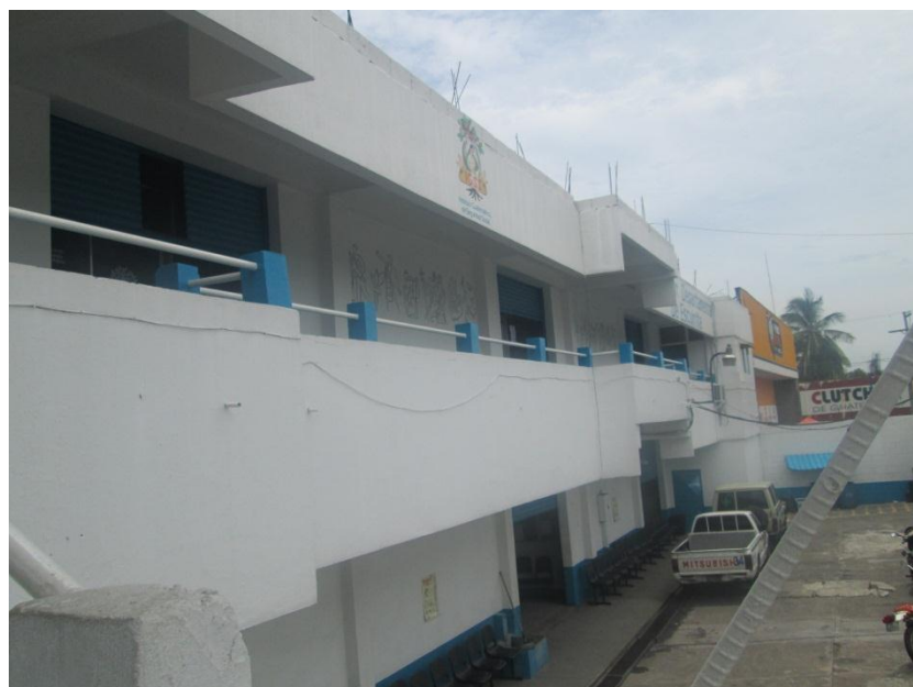
Foto No. 2 Instalaciones de la Delegación del IGSS de Escuintla. (12-julio-2014)
