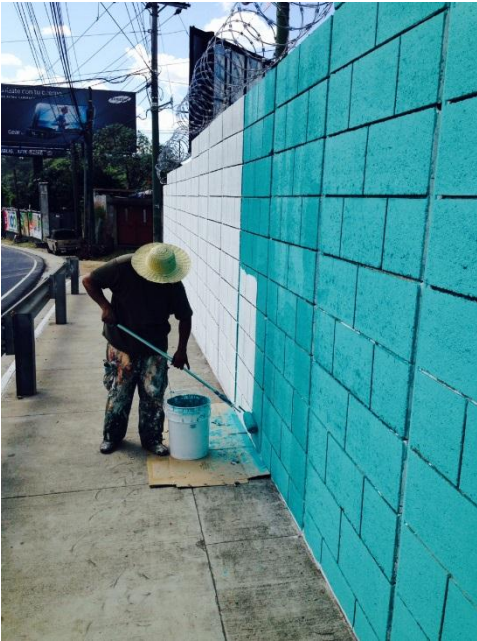
Fondeado del muro.
