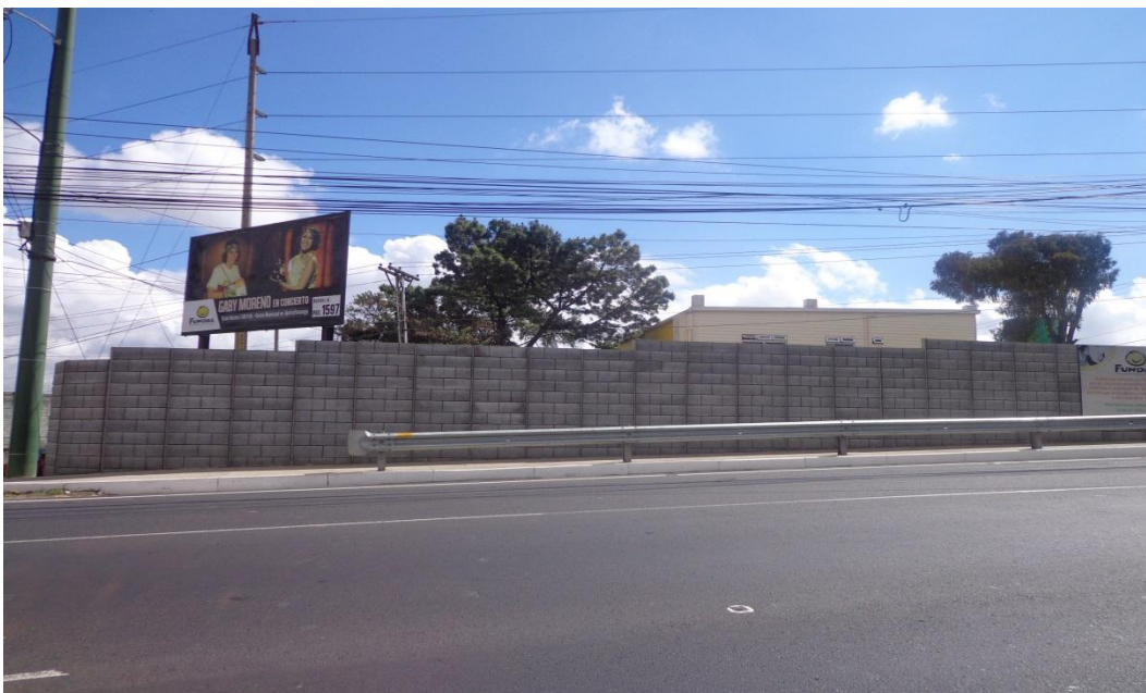
Muro y vallas exteriores de FUNDAL
