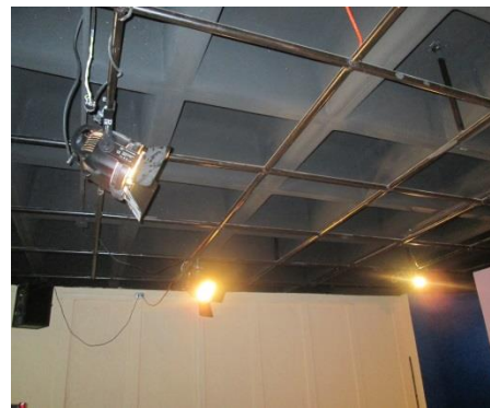
Iluminación actualizada e instalada correctamente
