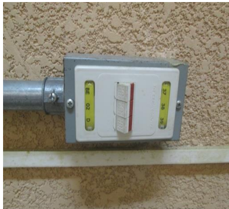
Instalación de tomas de Internet Fuente y fotografías: Brayan Mencos
