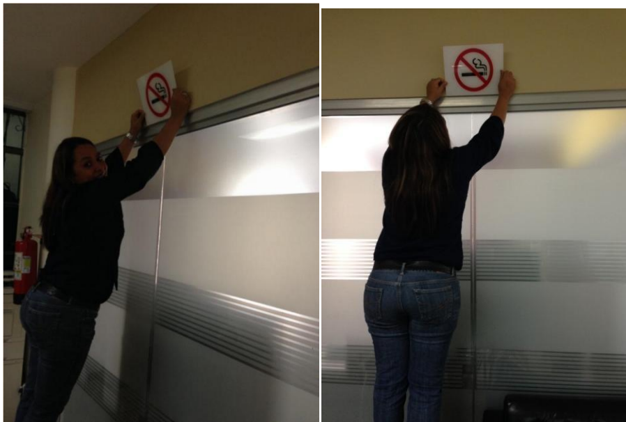
Rotulación del edificio ubicado en la 8ª. Avenida 10-57 de la zona 1, Claudia Carrillo el 20 de junio del año 2014.
