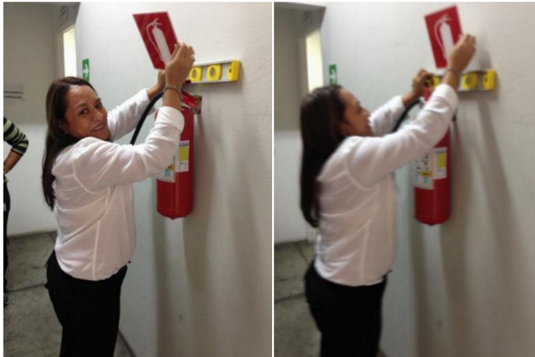
Rotulación llevada a cabo en el Edificio Casa de la Cultura ubicado en la 9ª. Ave. 10-26 de la zona 1, efectuado por Claudia Carrillo y Marvin Chiquín Pacay, el 10 de junio del presente año.
