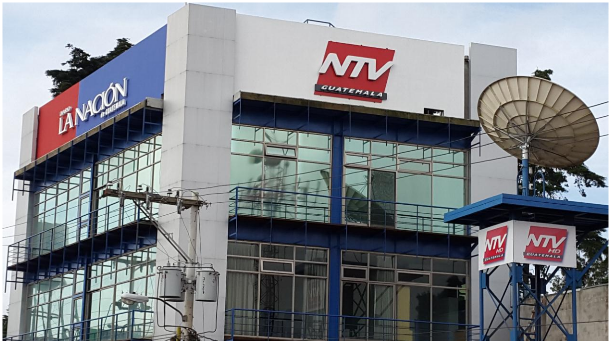
Edificio del Consorcio Nacional de Medios. Kilometro 16.5 Carretera a El Salvador
