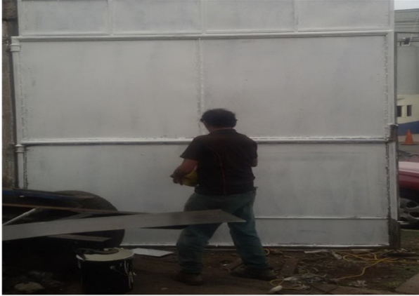
Reparación de portones de la bodega Central
