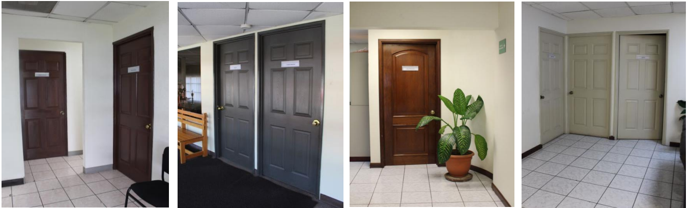
Fotografías de la aplicación del producto final en puertas de diferentes áreas dentro de la planta
