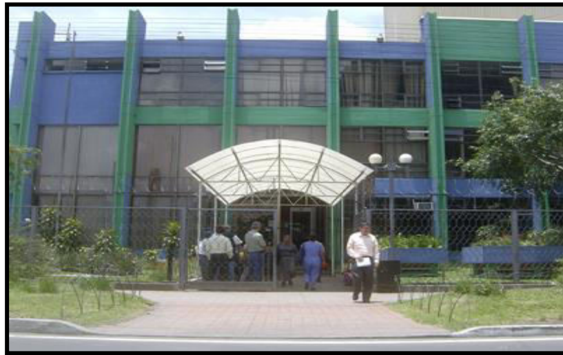
Fuente: Edificio del Registro Mercantil, 3er. Nivel, Oficinas Centrales DIACO.
