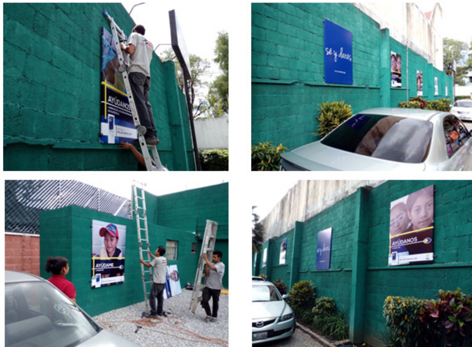
Ilustración 12 Instalación de Mini Vallas e imágenes panorámicas de las mismas
