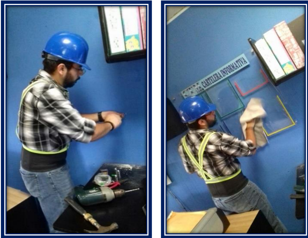
Ing. Jorge Vidal en instalación de Cartelera Informativa – Julio 2017.
