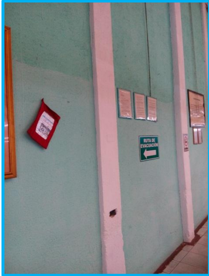
Colocación del Manual de Procedimientos en el lado izquierdo de la planta de Producción. –Junio 2017.
