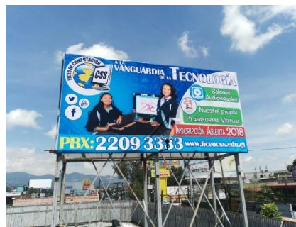
Estructura colocada en la terraza del colegio De zona 7, Calzada San Juan.
