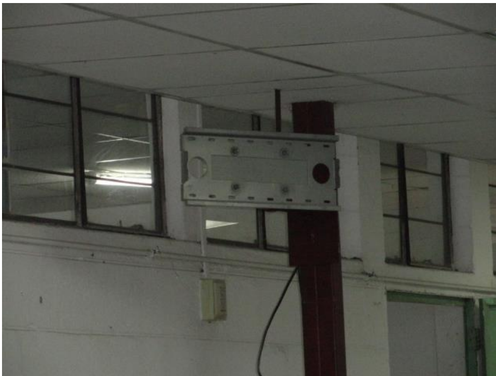
Área donde se colocará un monitor para el circuito cerrado y transmisión de material audiovisual (Pendiente de concluirse)
