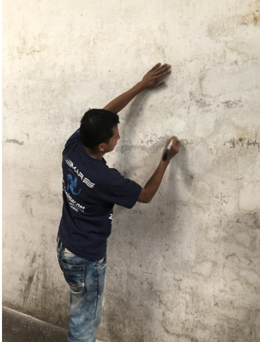
Ubicación de donde se colocará la cartelera informativa, proyecto a cargo de epesista Delmi Alicia Puente Pérez (2018).
