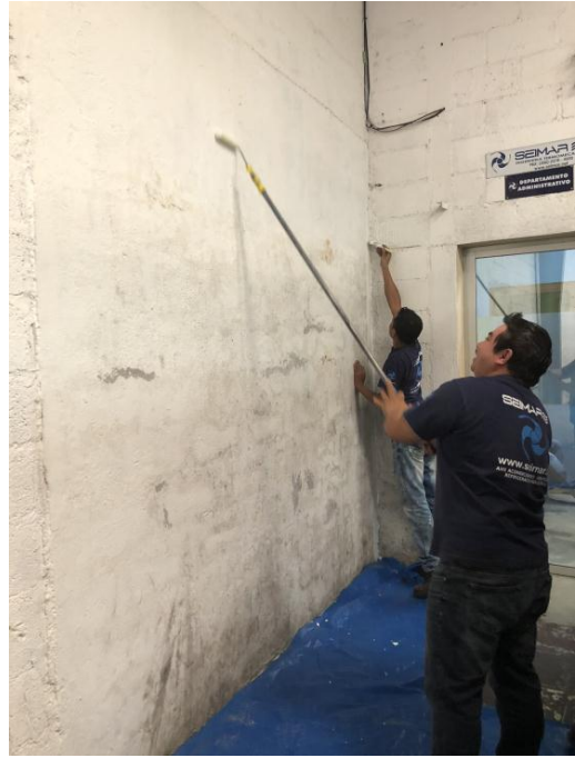
Colaboradores de la empresa limpiando el lugar de ubicación de la cartelera, proyecto a cargo de epesista Delmi Alicia Puente Pérez (2018).
