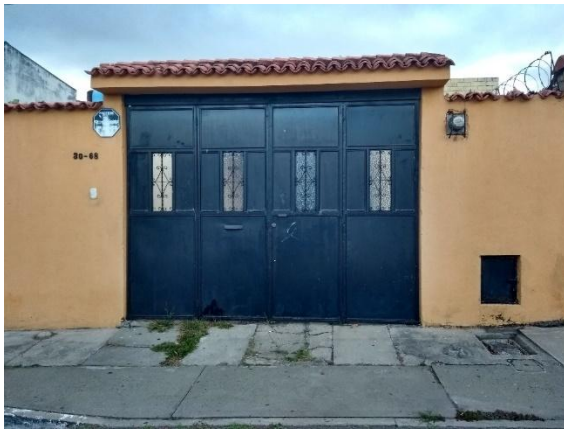
Referencia: Fachada exterior de instalaciones de Estigma Industria Serigráfica.
