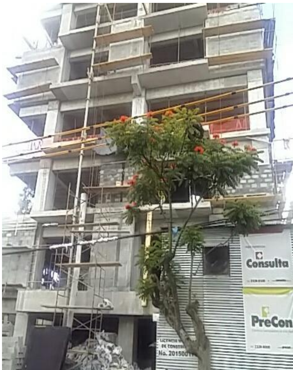
Fecha 11 de Junio al 15 de Julio 2018. Visita e inspección de muros para instalación fachaleta cerámica Edificio Doral ubicado en zona 15 vista Hermosa II
