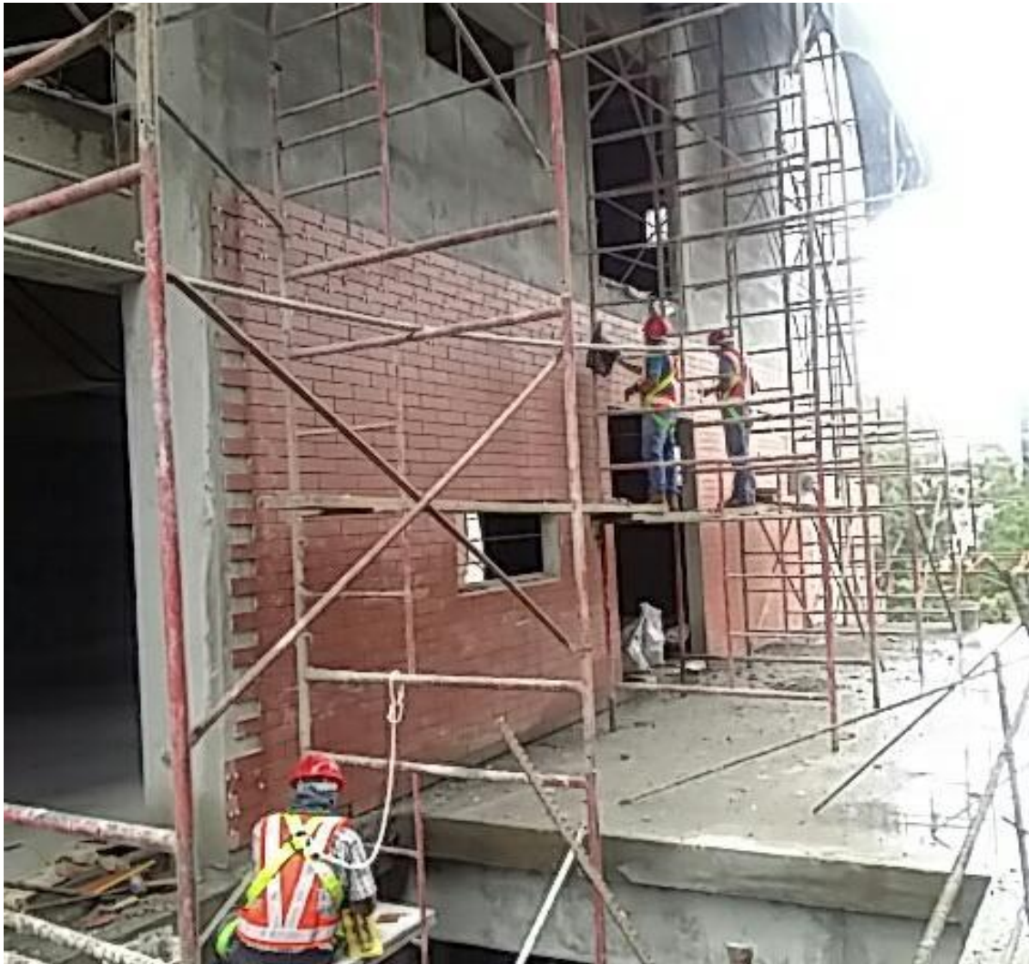
Fecha 11 de Junio al 15 de Julio 2018. Visita a obra instalación de fachaleta cerámica imitación ladrillo, edificio de apartamentos Doral ubicado en zona 15.
